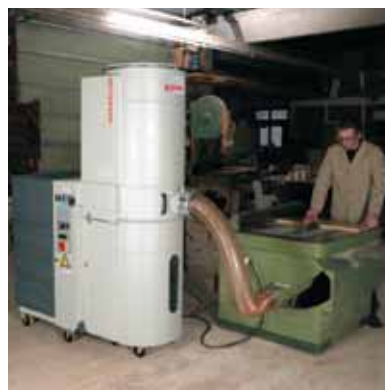
DUSTOMAT K an einer Holzkreissäge
